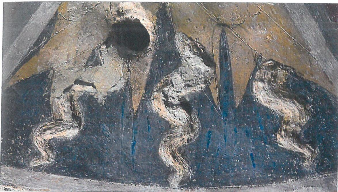
Fig. 5. Centro volta raggiato, intonaco a rilievo in corrispondenza dei raggi, foro di areazione della volta.
