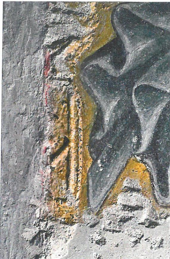
Fig. 13. «Gioacchino e l'angelo», particolare a luce radente della decorazione in rilievo dell'intonaco di sfondo a motivi geometrici, eseguita con malta liquida stesa a pennello.
