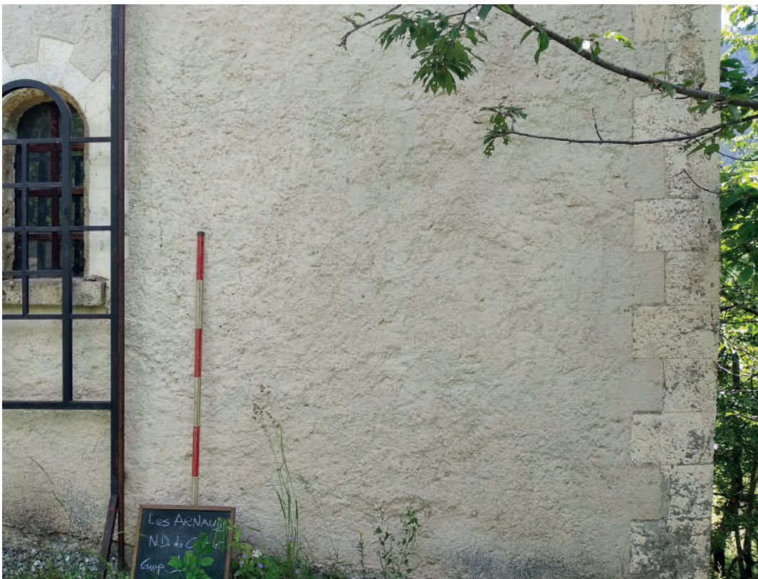
Paroi extérieure est. Détail de la maçonnerie
