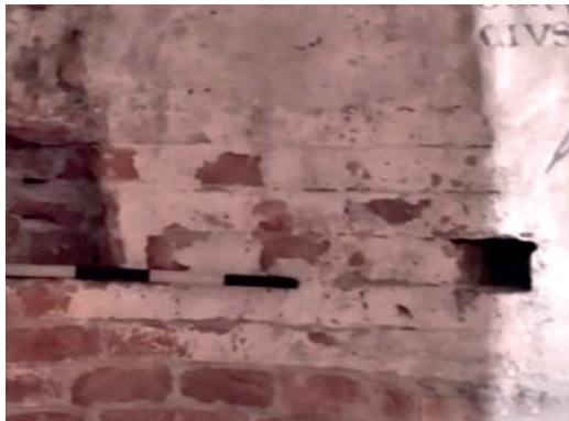
Logement et niches à relier à une potentielle structure en bois insérée dans la maçonnerie et finie par la fresque de St Gaudence. (cf. Peyrani Baricco 2014, p. 204)
