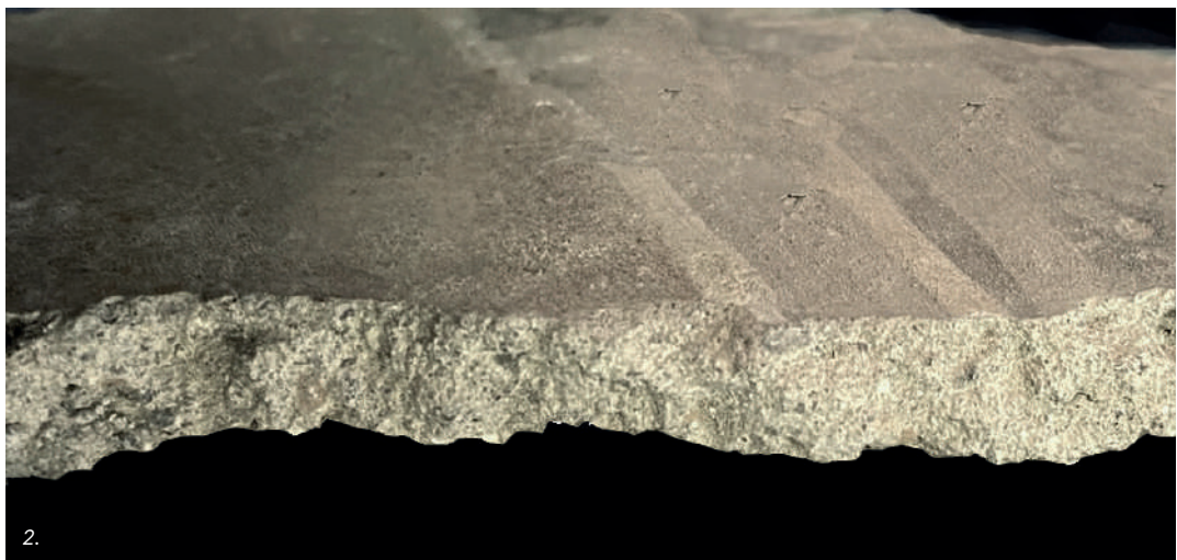
2. Stratigraphie du secteur est. Les deux enduits ne semblent pas être liés l'un à l'autre, en revanche la couche la plus profonde peut être associée à un enduit préexistant
