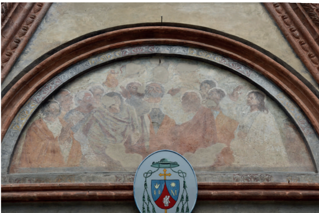
Lunette au-dessus de l'entrée centrale
