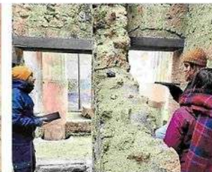
Valutazione della solidità delle pareti
