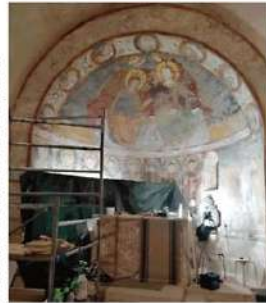
Concluso l'intervento di restauro degli affreschi, completati nella chiesa di San Giovanni al Monte.
