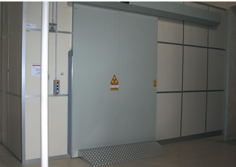
Fig. 4 Il locale radioprotetto con, in primo piano, la porta scorrevole schermata per l'accesso delle opere.
