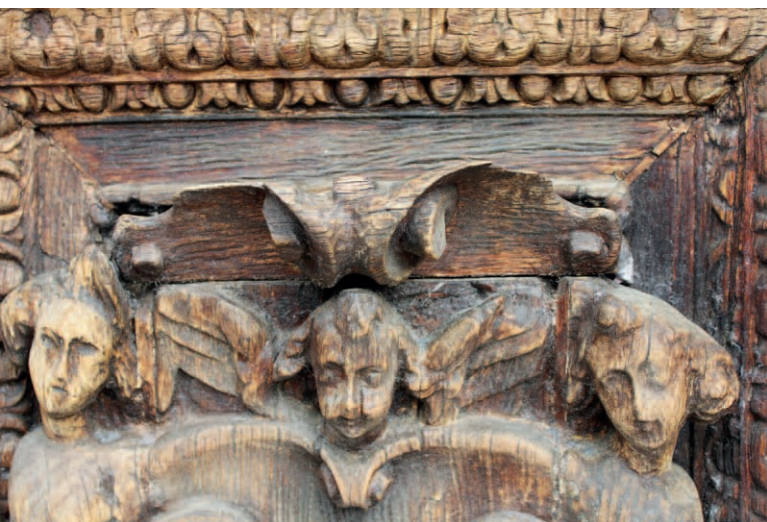
Figg. 9-10-11 - Fenomeni di erosione e consumo delle parti scolpite.
