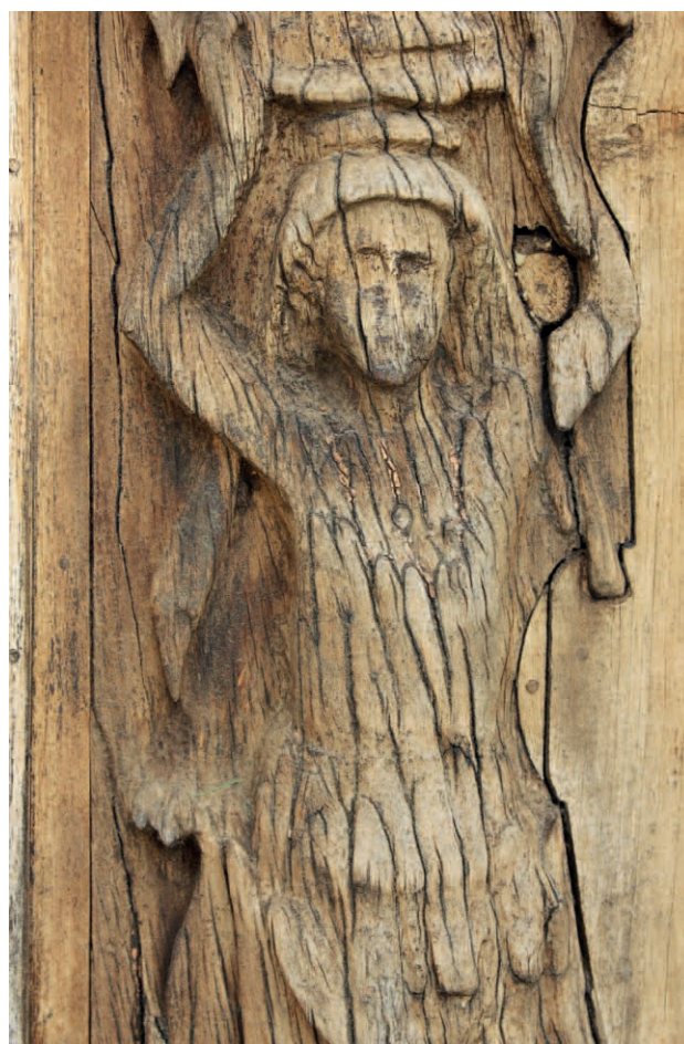
Figg. 9-10-11 - Fenomeni di erosione e consumo delle parti scolpite.
