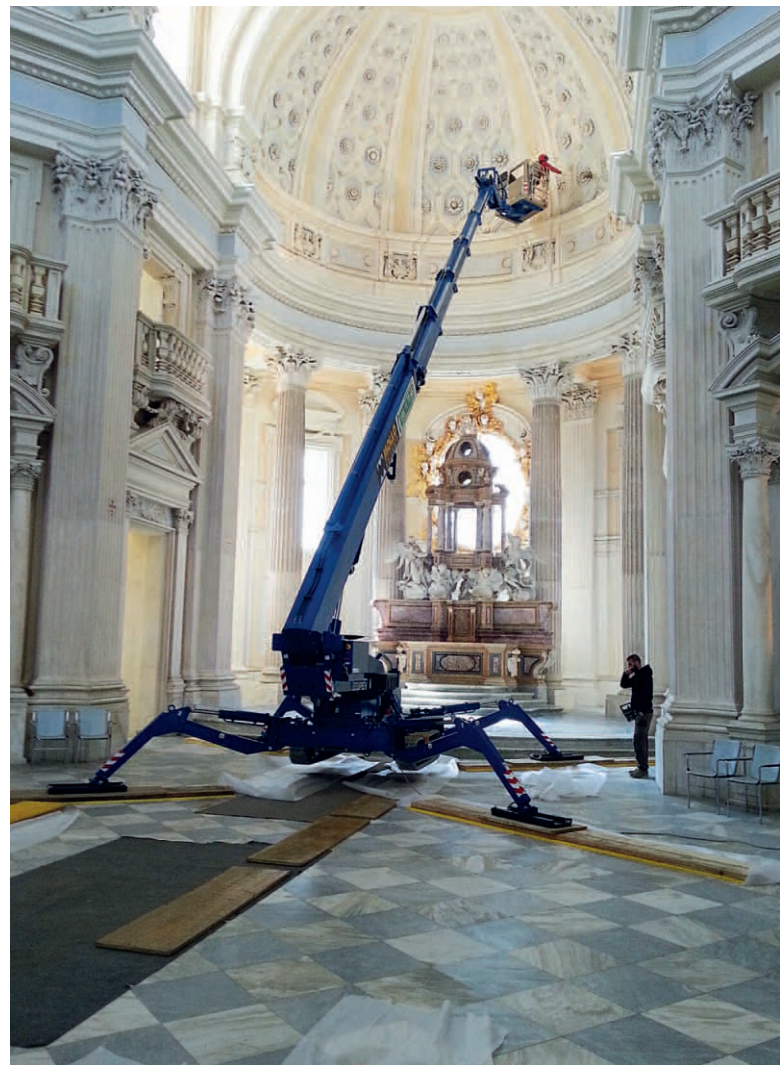
Fig. 1 - Monitoraggio e manutenzione degli stucchi nella chiesa di sant'Uberto.
