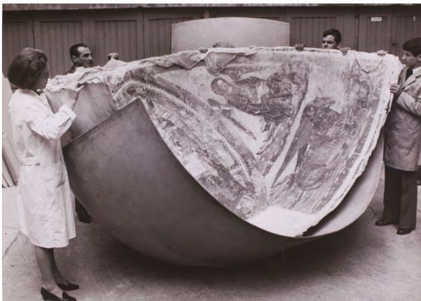
Operazioni di deposizione sul nuovo supporto del dipinto murale strappato, catino absidale, Chiesa di San Pietro, Robbio, 1964.
